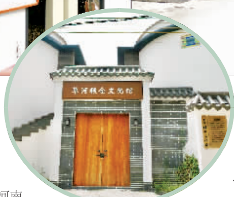
◀粮仓旧址修复变为草河粮仓文化馆。
