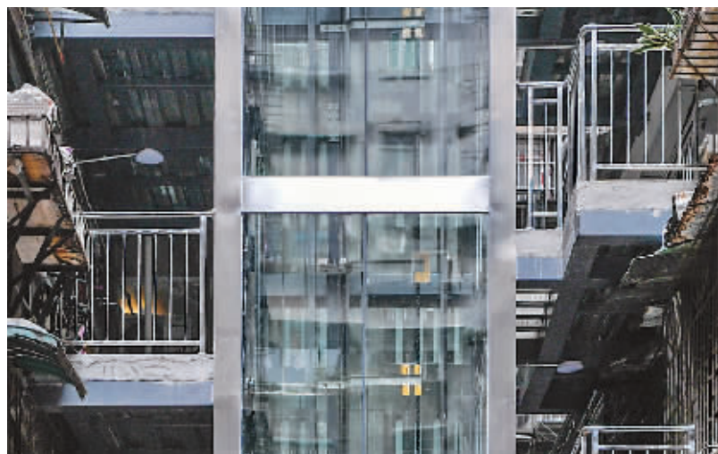
位于越秀区濠畔街的两栋居民楼楼层相差1.5米,因此采用“错层共享”的方式加装电梯。信息时报记者 胡瀛斌 摄
