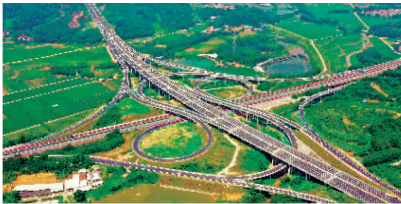
惠清高速东城枢纽互通。通讯员供图
