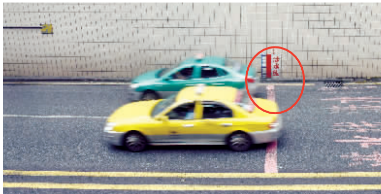
中大北门隧道的涉水线警示标志及标尺(红圈处)。
