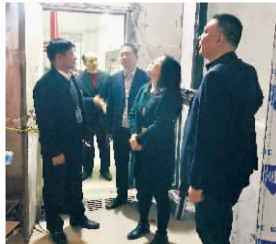
天河区委领导检查天平架装饰材料城微型消防站建设情况。 通讯员供图
