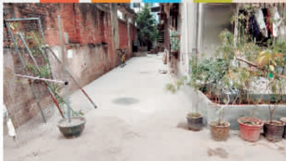
小港社区涌边东九巷 27、28 号大楼改造后变得干净整洁。
