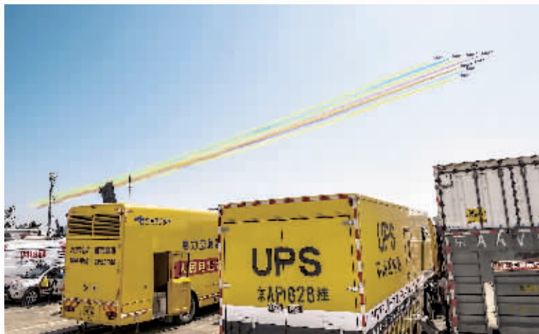
UPS电源车为航展保障电力供应。珠海供电局供图
