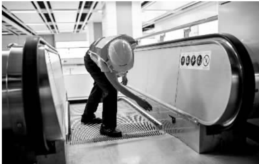
地铁工作人员在检查站点电梯设备。通讯员供图
