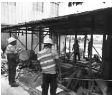
9月6日,化龙镇组织拆除违章厂房。通讯员供图
