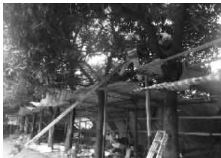
洛浦街整体拆除东乡村下沙路综合市场5700平方米。通讯员供图
